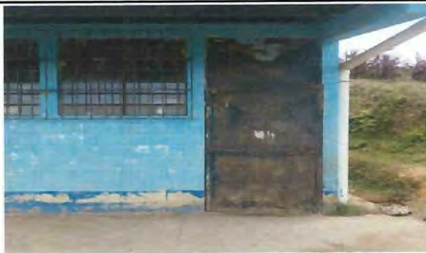
Foto 5: Las puertas se encuentran en mal estado que requiere sustitución de manera inmediata por seguridad del establecimiento.
