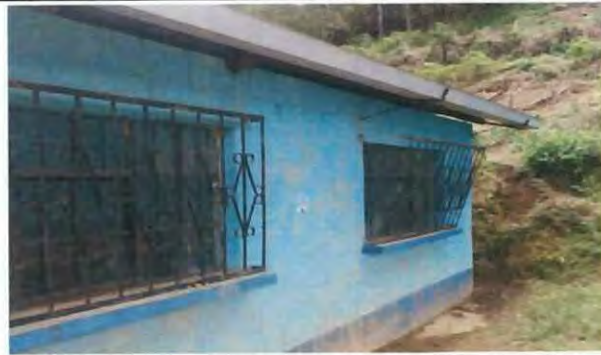
Foto 6: Mantenimiento de los balcones de metal por su deterioro en toda las instalaciones del centro educativo.
